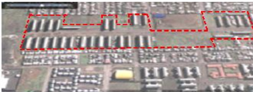
Imagen 1: Población Michaihue 600 original, con 30 bloques construidos (año 2000).
